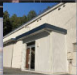
第五工場(非ステロイド) 工程: 原料試験
