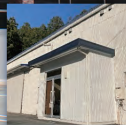
第五工場(非ステロイド) 工程: 原料試験
